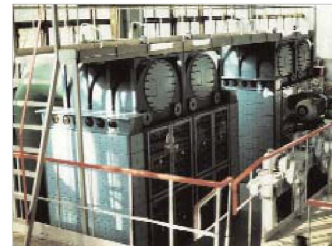
Figure 22. UV planta de agua potable 405.000 m<sup>3</sup> por día, Tolyatti (Rusia).
